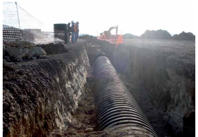
Foto 8.4 Aspecto del acostillado antes de la prueba de hermeticidad
