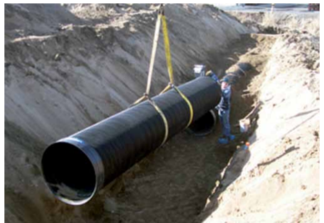
Foto 8.1 Descarga correcta
