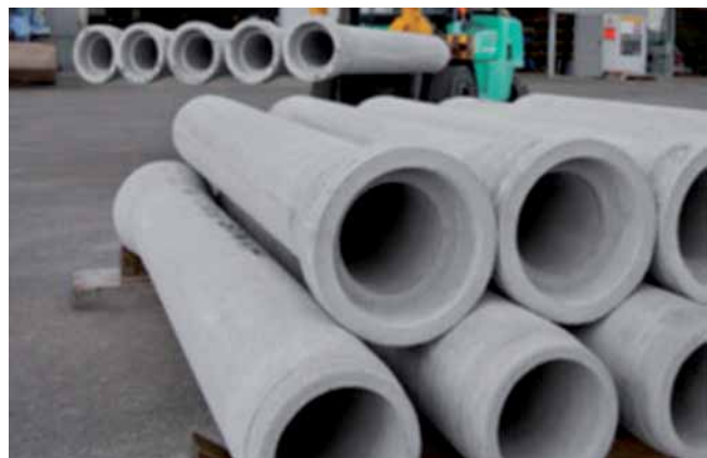
Foto 5.7 Poner cuñas de madera o en su defecto piedras para que el tubo no ruede.
