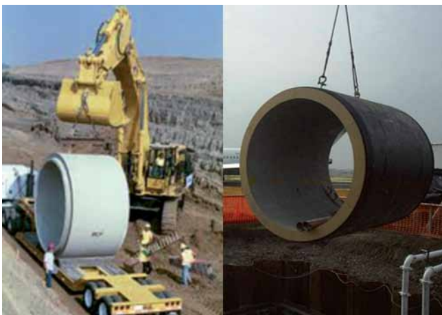
Foto 5.3 y 5.4 Ejemplos de levante de tubería.
