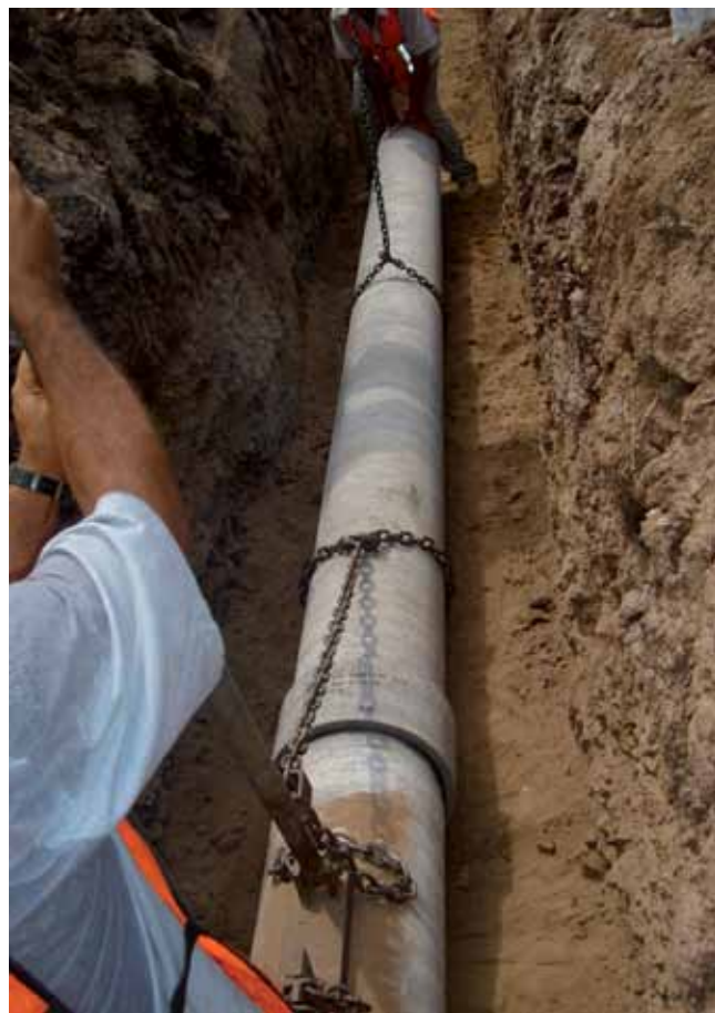
Foto 2.10 Encampanado dentro de zanja
