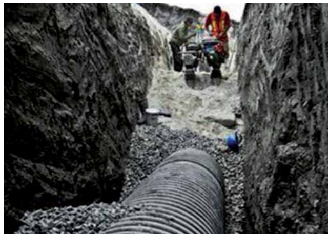
Foto 8.5 Acostillado de alta resistencia con grava y relleno final de arena
