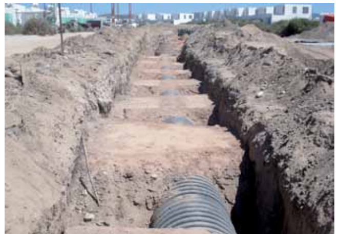
Foto 8.4 Aspecto del acostillado antes de la prueba de hermeticidad
