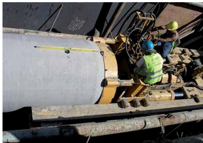
Figura 5.8 Ejemplo de Construcción Hincado de Tubería
