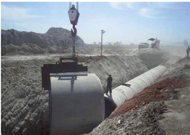
Foto 5.13 c) Con orificio de maniobra
