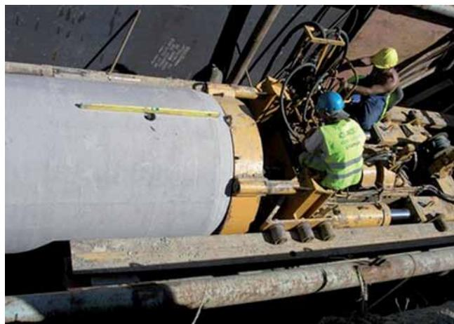
Figura 5.8 Ejemplo de Construcción Hincado de Tubería
