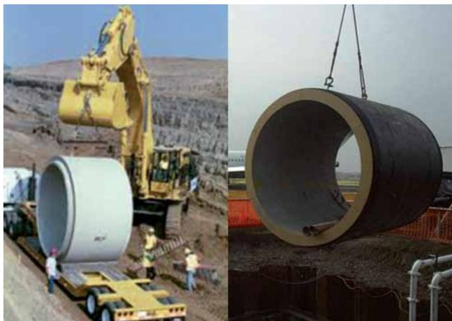
**Nota:** En caso de que el tubo tenga que ser desplazado por rodamiento, se recomienda que se coloquen tabloncillos de madera, para guiar el tubo y éste no sufra daño en espiga o caja.
